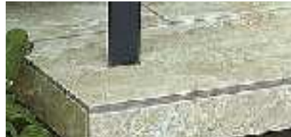
手すりや点検口に干渉する場合には穴あけ加工も可能。
