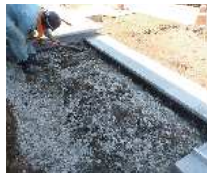
8 製品の内側にあるボルトの周りを埋め戻します。
