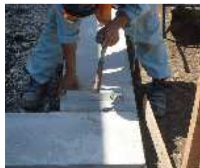
7 製品の高さと位置を確認しながら、上面が水平になるように微調整します。
