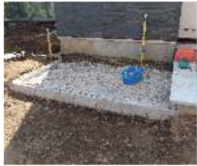
1 製品を設置する場所にCBを並べ、水平になるように調整します。
