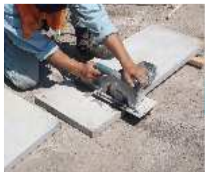
6 現場の状況に合わせて、製品をカットしてサイズを調整します。
