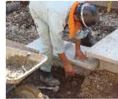
5 ボルトがCBの内側に来るように、製品をCBの上に乗せます。(事前にボルトの部分を少し掘る)
