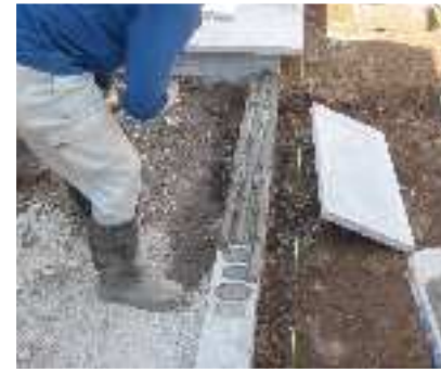
4 CBの上面にモルタルをビート状に設置します。
