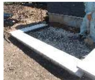
9 埋め戻した後、生コンを打設します。
