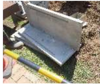
3 製品の裏側にあるインサート(W3/8)に全ネジボルト(L=150)を4本取り付けます。
