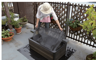
透水フィルターを敷き詰めます。
