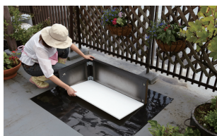
ダンプレートを設置します。
